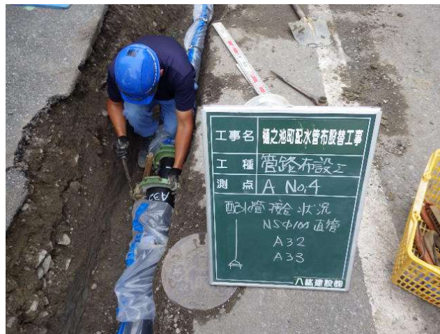
②管布設工
