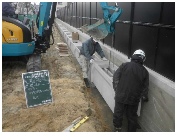
②側溝整備工
