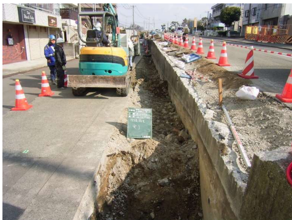
①掘削・盛土工
