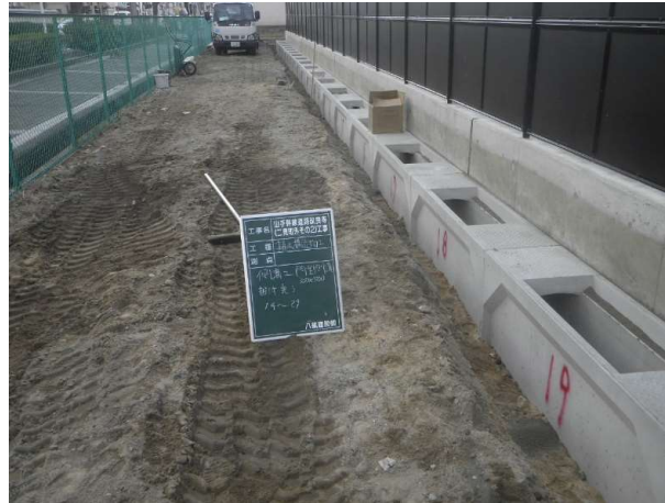
②水路整備工
