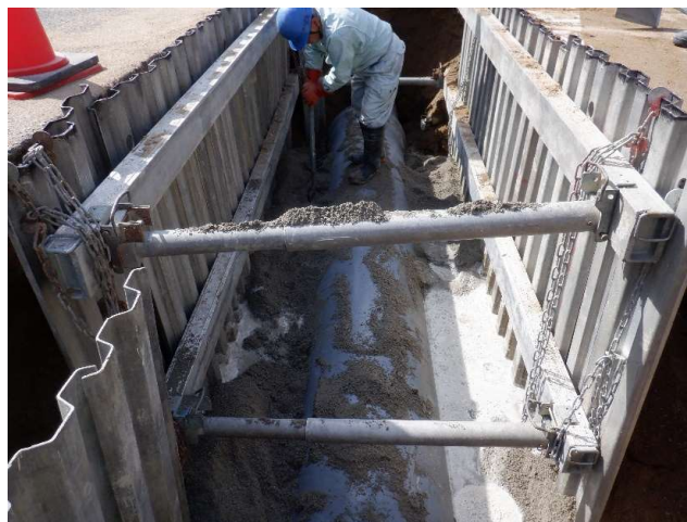
②管布設工
